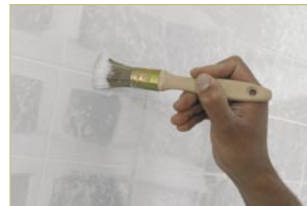
Grundning af fuger med pensel.
